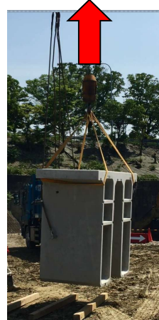
補巻フックを使用し、地面から50cm程度吊り上げる。
