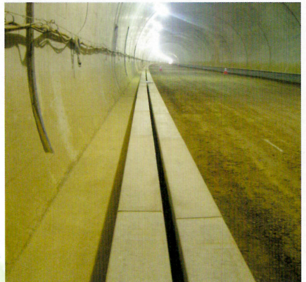
第二東名 掛川トンネル舗装工事
