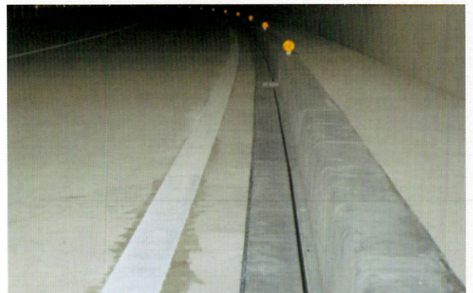
岐阜県 日当トンネル
