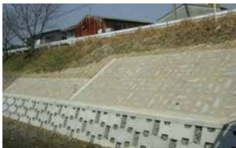
西三河建設事務所：伊賀川 岡崎市
