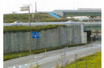
金沢河川国道事務所：国道8号金沢東部環状道路 金沢市
