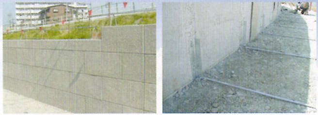
↑ パネル背面と補助アンカー
