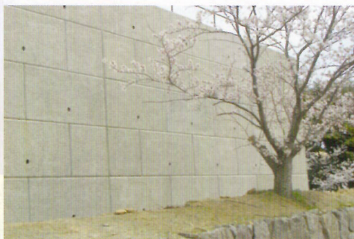
民間工事：幡豆町
