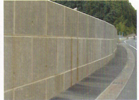
民間工事：滋賀県栗東市
