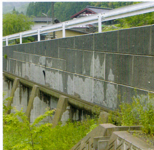
中濃地域農山村整備事務所：郡上南部 郡上市
