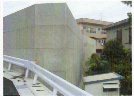
民間工事：三重県四日市市
