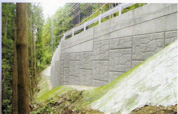
矢作ダム管理所：工事用道路 豊田市
