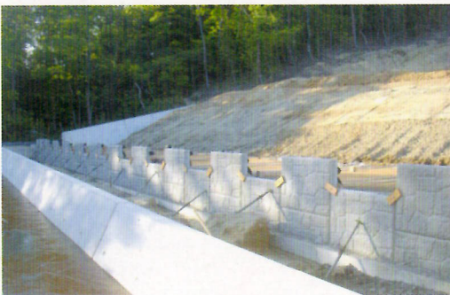
2 基礎パネルの設置
