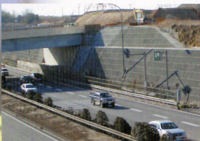
豊田加茂建設事務所：豊田知立線 三好町
