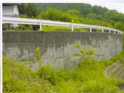
中濃地域農山村整備事務所：郡上南部 郡上市
