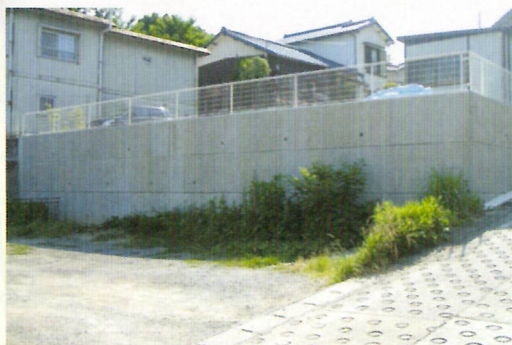
民間工事：愛知県瀬戸市
