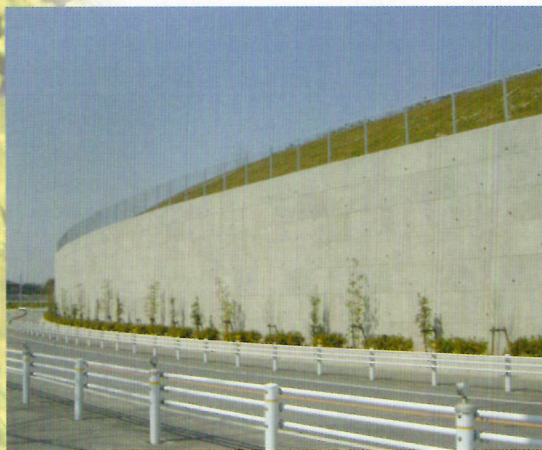
民間工事：愛知県岡崎市
