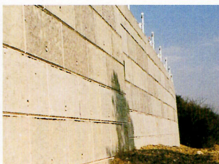
大垣建設事務所：牧田関ヶ原線 大垣市
