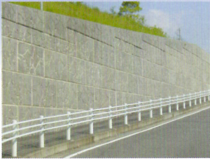
水質源開発公園川上ダム建設所：川上ダム 伊賀市
