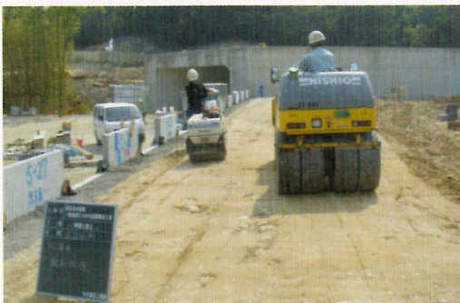
3 敷き均し・転圧
