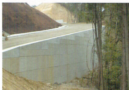
浪速国道事務所：第2阪和国道 阪南市
