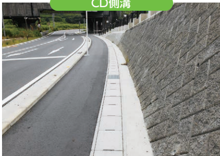
袋井土木事務所：吉沢金谷線 菊川市
