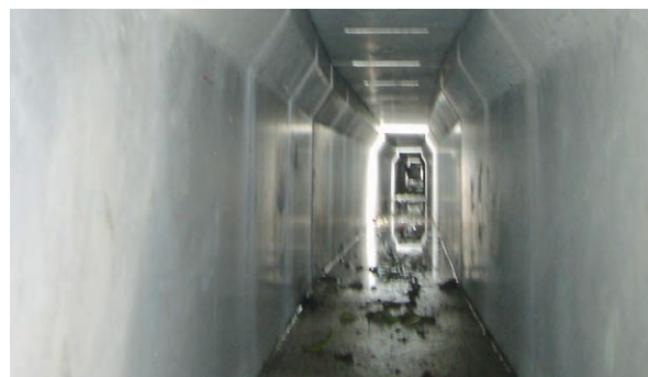
インバートコンクリート打設
