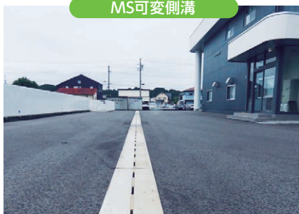
民間工事：掛川市
