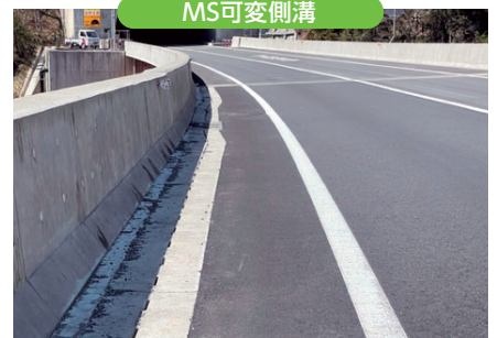
飯田国道事務所：国道19号桜沢・藪原地区 塩尻市
