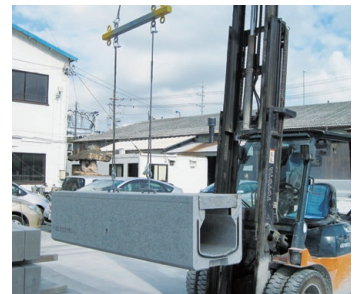
一体化吊実験
