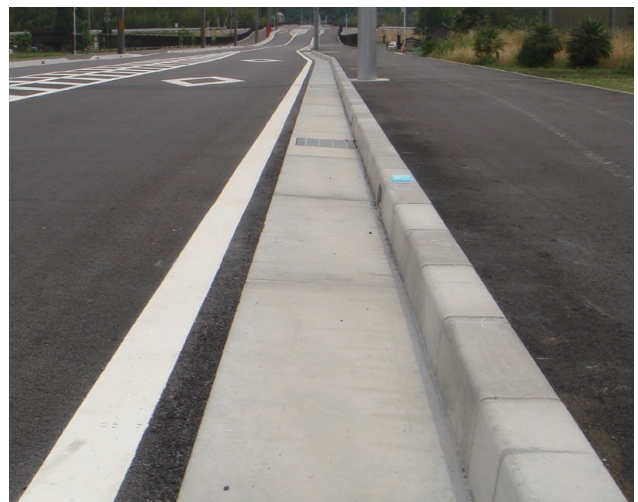
南丹土木事務所：国道477号
