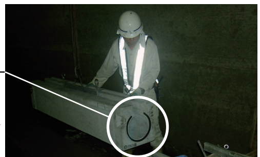
円型側溝布設状況
