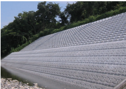
四日市建設事務所：三滝川 菰野町
