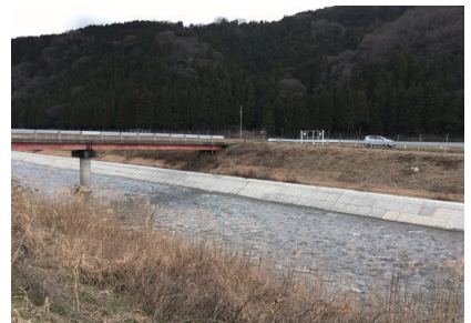
高島土木事務所：知内川 高島市
