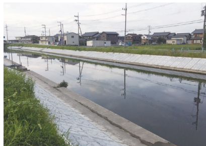
湖東土木事務所：野瀬川 彦根市
