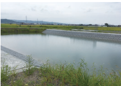
高島土木事務所：鴨川 高島市
