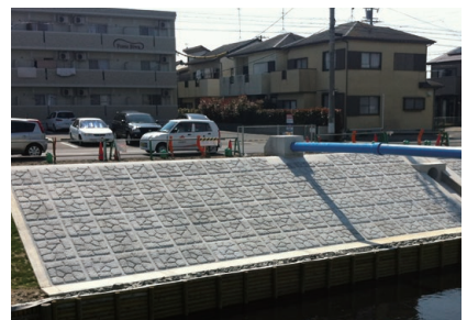
浜松市役所：植松町地内水管橋
