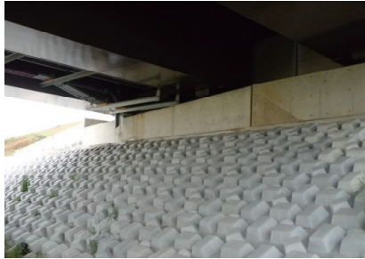
豊橋河川事務所：矢作川 豊田市
