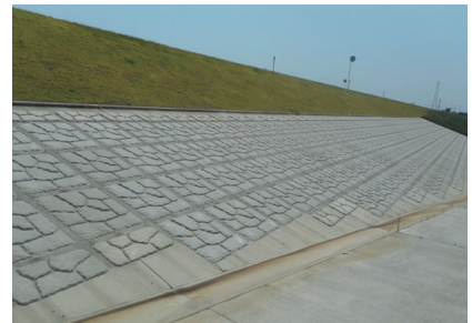
木曽川下流河川事務所：揖斐川 海津市
