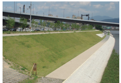
京都土木事務所：鴨川 京都市
