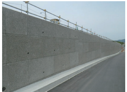
NEXCO西日本：湯浅御坊道路井関トンネル 広川町
