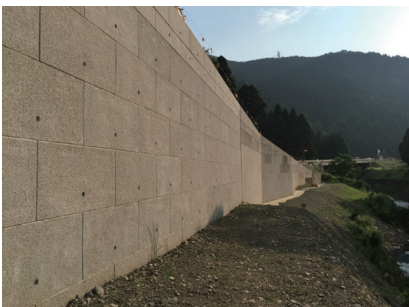
大垣土木事務所：牧田関ヶ原線 関ヶ原町
