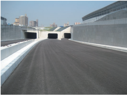
愛知国道工事事務所：国道302号 名古屋市
