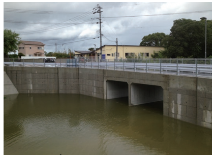
広川町役場：町道殿山本線
