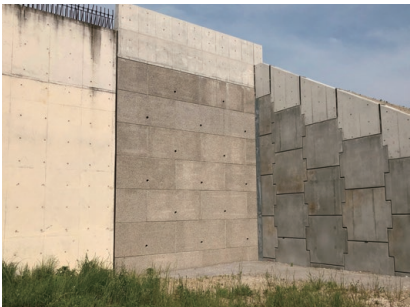
兵庫国道事務所：西脇北バイパス津万地区 西脇市
