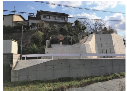
京都国道事務所：精華拡幅山田喜殿協地区 精華町
