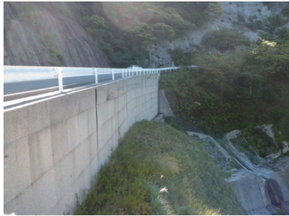
桑名建設事務所：306号線 いなべ市
