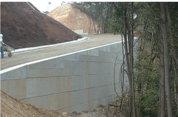
浪速国道事務所：第二阪和国道 阪南市
