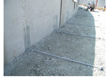
↑パネル背面と補助アンカー
