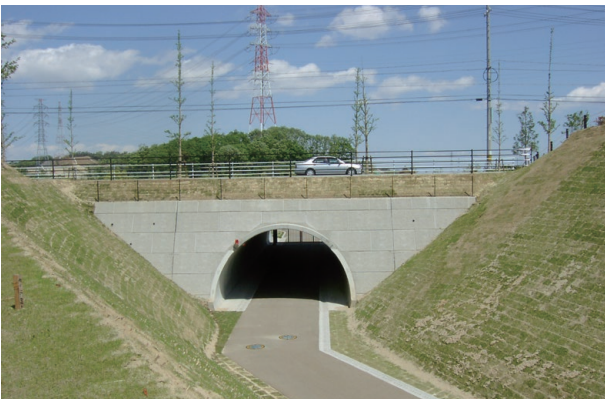
都市基盤整備公団：桑名市総合運動公園 桑名市
