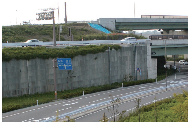
金沢河川国道事務所：国道8号金沢東部環状道路 金沢市
